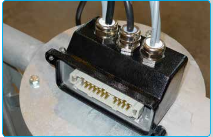
Connector voor de windmeettechniek met deelbare inzetstukken van het UNI Dicht®-systeem.
