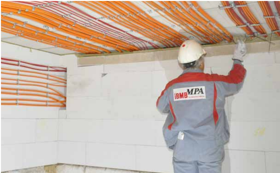
Installatie van de JMV beugels plus kabels in de testruimte van iBMB.
